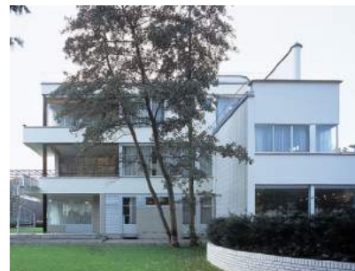
Achtergevel van Huis Sonneveld
